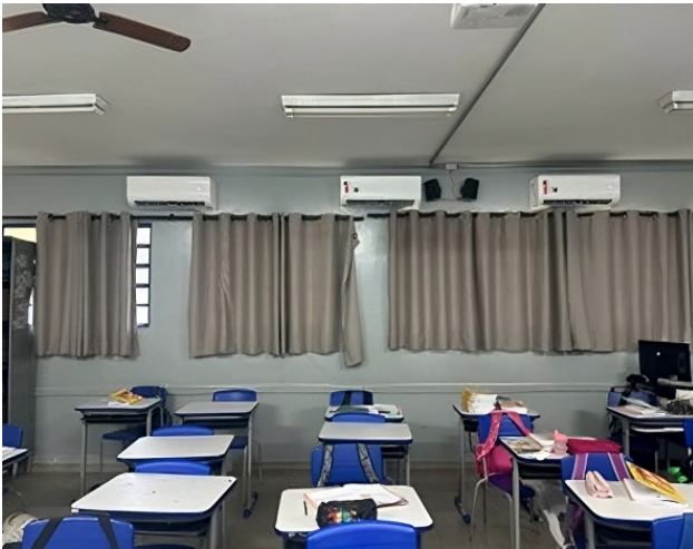
Figura 2 – Sala de aula do ensino fundamental (a)
