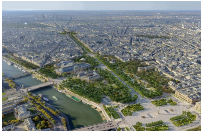
Figura 3 – Intervenção na avenida Champs-Élysées
